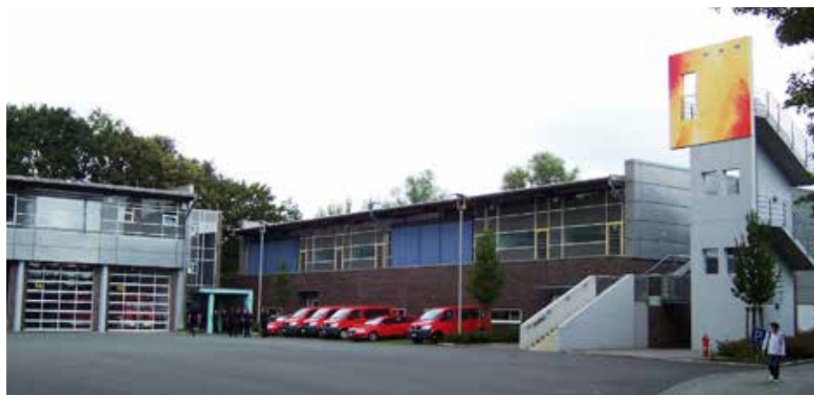
Sporthalle und angrenzende Fahrzeughalle.
