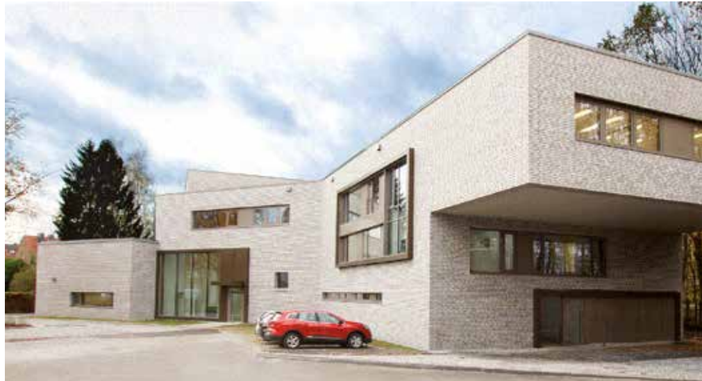
Das „Lehrsaalgebäude C“ wurde eigens für die Ausbildung der Krisenstäbe errichtet. Es verfügt über optimale räumliche Bedingungen und eine hochmoderne technische Ausstattung.
