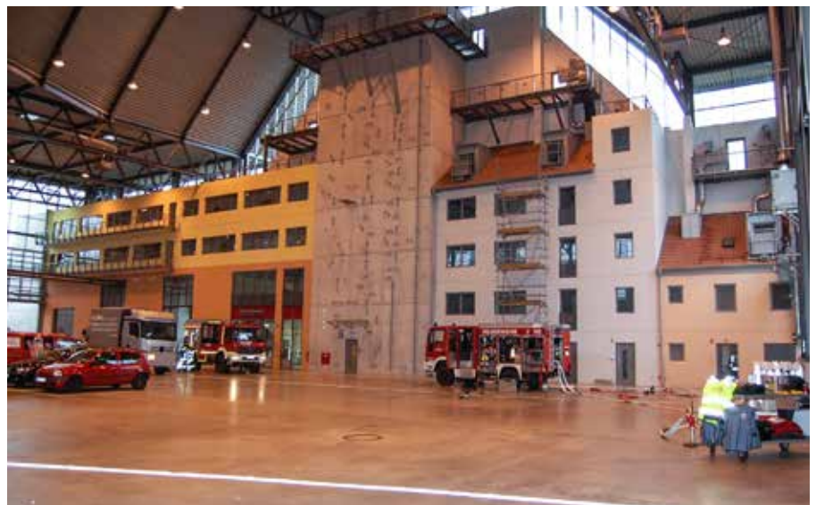
In den bis zu 30 Meter hohen Fassadenwänden sind die verschiedensten Übungsobjekte, vom Hochregallager bis zur Krankenhausabteilung, integriert.
